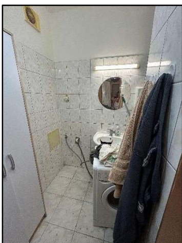
Obr. č. 12 BD č. s. 93 na p. č. 3 962, Nové Mesto n. V. Pohľad do kúpeľne bytu č. 32
