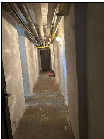
Obr. č. 18 BD č. s. 93 na p. č. 3 962, Nové Mesto n. V. Pohľad do hlavnej chodby v podzemnom podlaží
