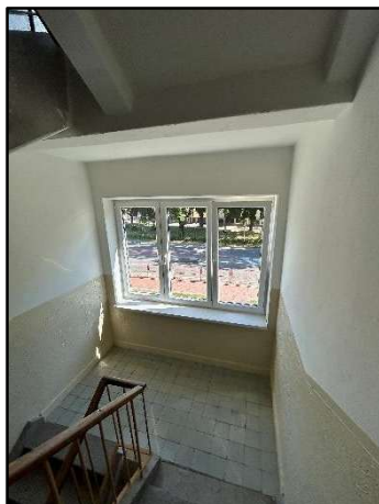
Obr. č. 17 BD č. s. 93 na p. č. 3 962, Nové Mesto n. V. Pohľad do schodiska vchodu č. 18
