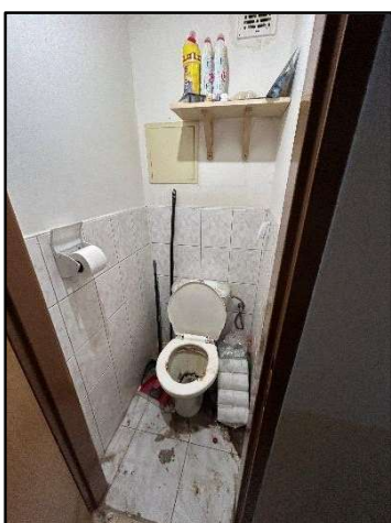
Obr. č. 14 BD č. s. 93 na p. č. 3 962, Nové Mesto n. V. Pohľad do WC bytu č. 32na vchod č. 18
