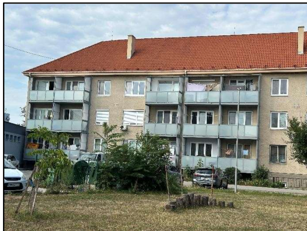
Obr. č. 05 BD č. s. 93 na p. č. 3 962, Nové Mesto n. V. Pohľad na južnú fasádu orientovanú do dvora
