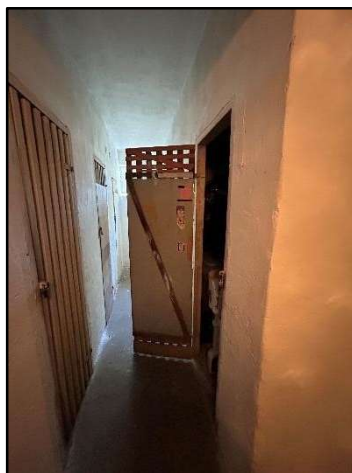
Obr. č. 19 BD č. s. 93 na p. č. 3 962, Nové Mesto n. V. Pohľad na vstup do pivnice č. 32 užíwanej s bytom č. 32
