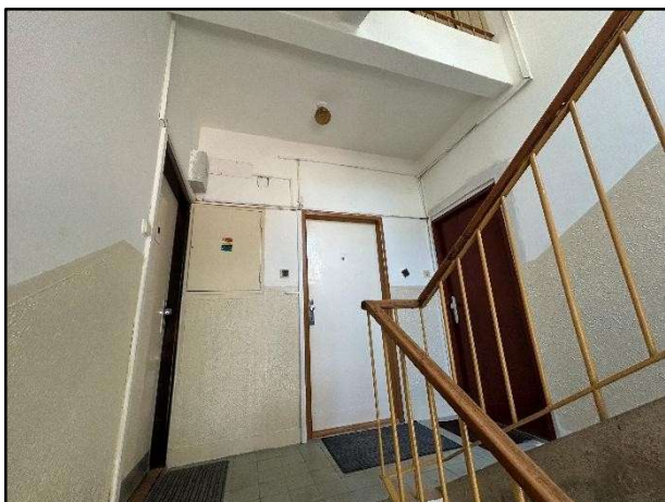
Obr. č. 06 BD č. s. 93 na p. č. 3 962, Nové Mesto n. V. Pohľad na vstupné dvere do bytu č. 32
