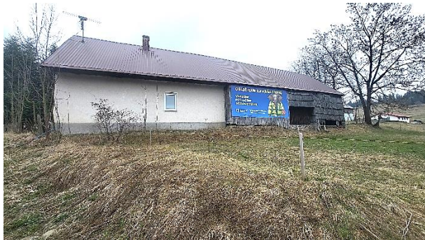
Hosp. budova p. č. 284/3 + RD s. č. 51-bočný pohľad
