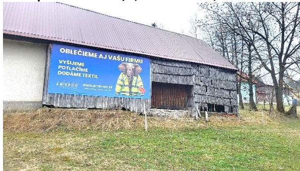
Hosp. budova p. č. 284/3 – bočný pohľad
