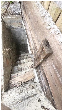
Schody do pivnice
