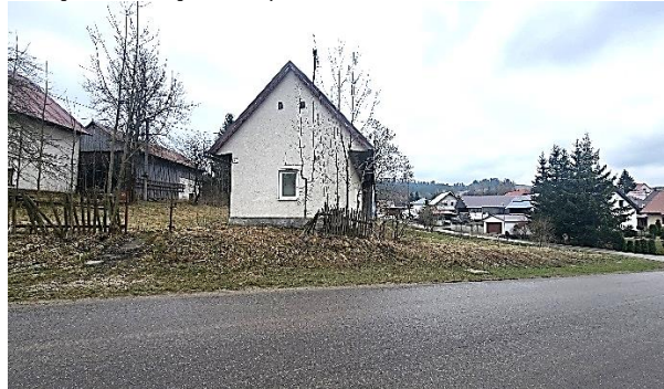
RD s. č. 51 – pohľad od cesty
