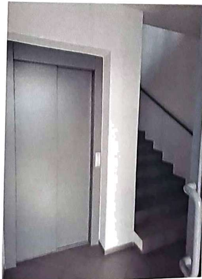
Spoločné priestory bytového domu
