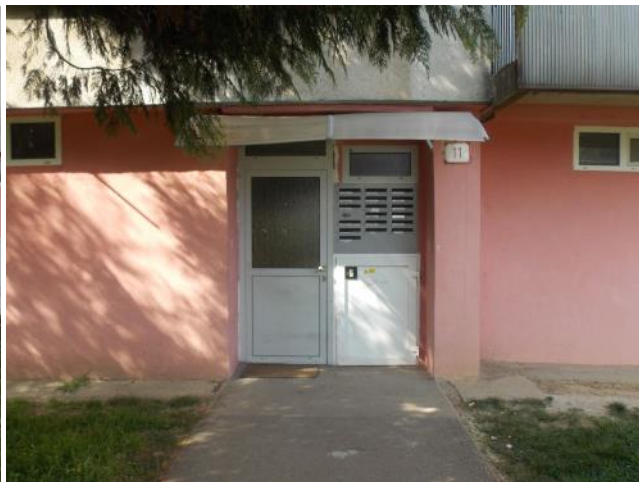
vstup do BD z južnej strany (hlavný vstup)
