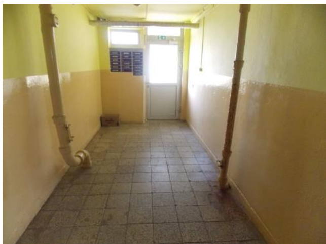
spoločné priestory BD (vstupná chodba)
