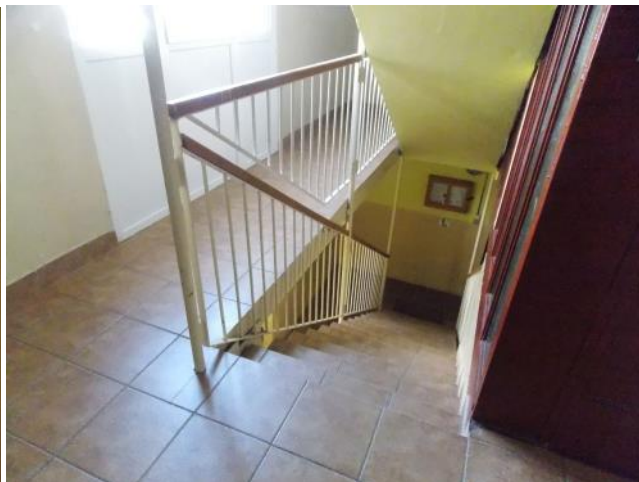
spoločné priestory BD (schodisko)
