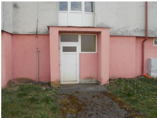
vstup do BD zo severnej strany (zadný vstup)
