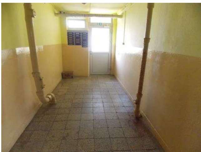
spoločné priestory BD (vstupná chodba)
