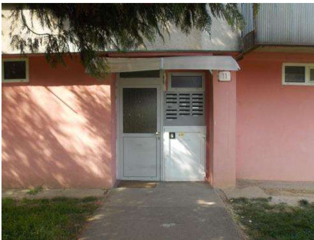
vstup do BD z južnej strany (hlavný vstup)
